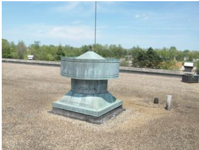
Roof Exhaust Fan
