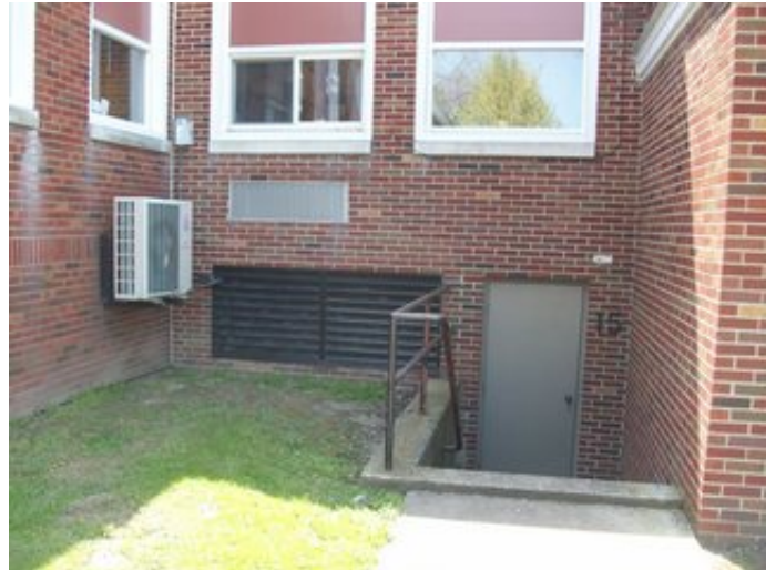
MiniSplit Condenser Unit
